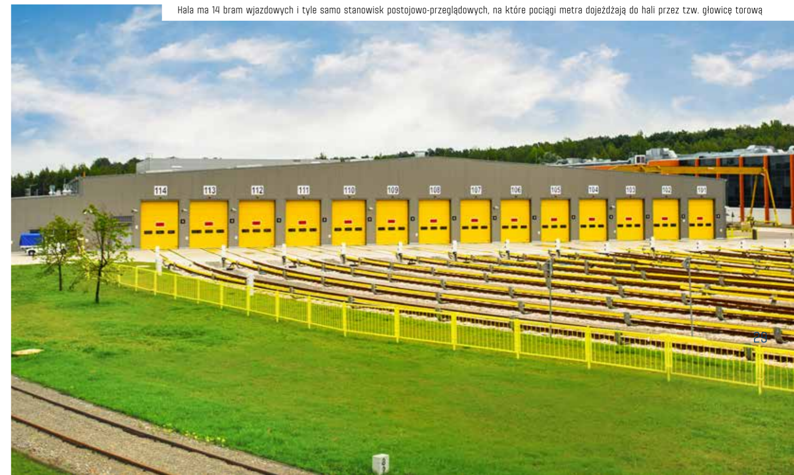
Hala ma 14 bram wjazdowych i tyle samo stanowisk postojowo-przeładowych, na które pociągi metra dojeżdżają do hali przez tzw. głowicę torową
