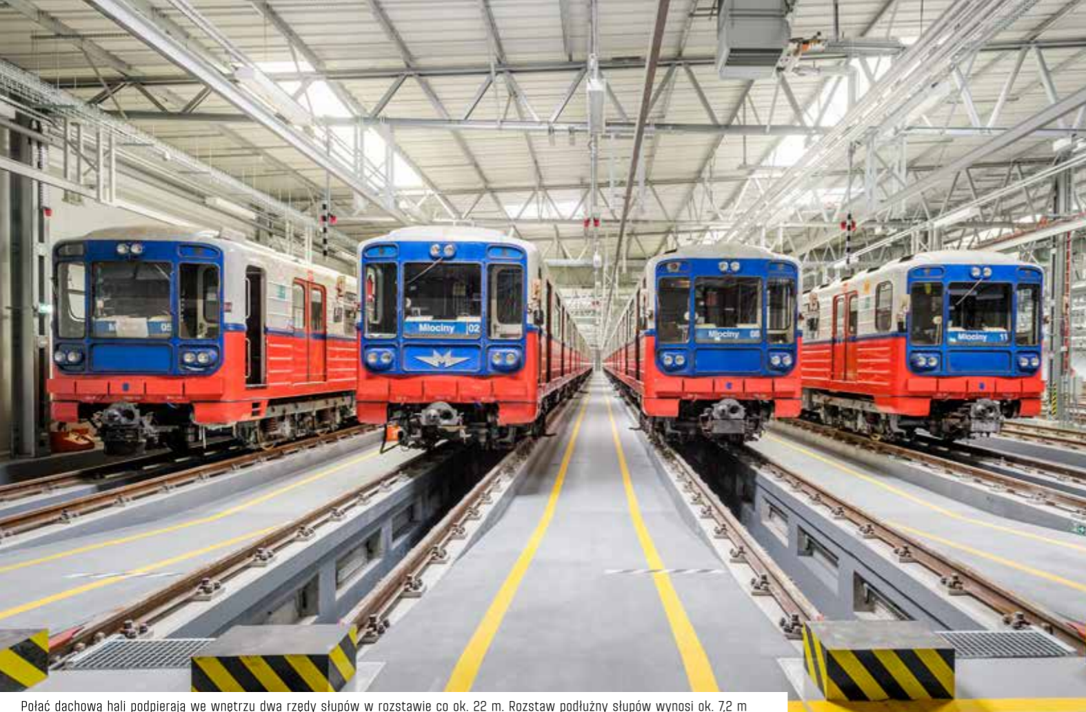
Połąc dachową hali podpierają we wnętrzu dwa rzędy słupów w rozstawie co ok. 22 m. Rozstaw podłużny słupów wynosi ok. 7,2 m
